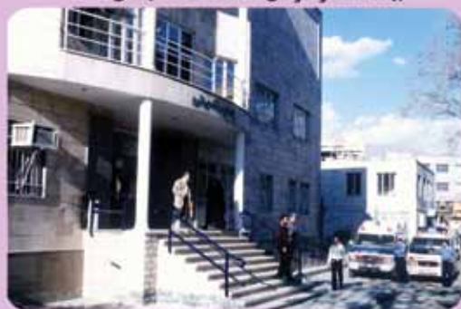
پلی کلینیک تخصصی کرج
